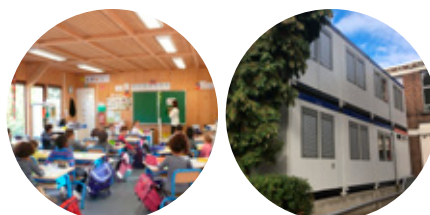
Modules préfabriqués en bois
